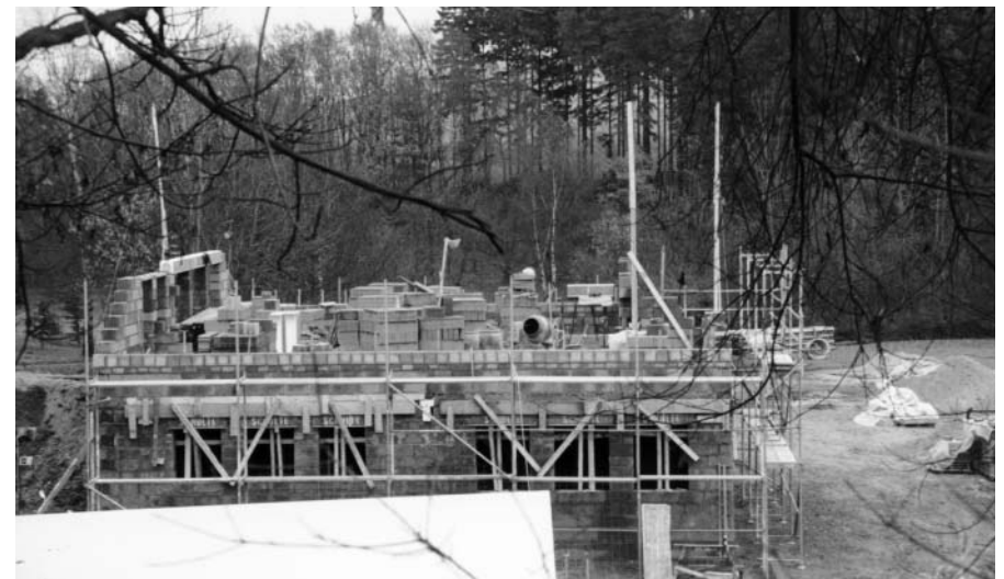
Nov. 1995 Der Baufortschritt nach "nur" 4 Wochen Bauzeit
