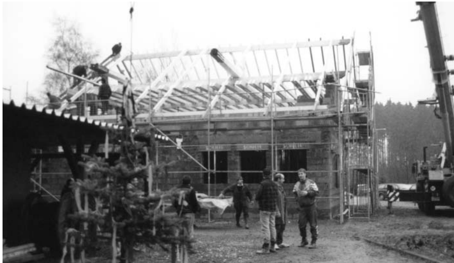
Dez. 1995 Richtfest nach "nur" 7 Wochen Bauzeit
